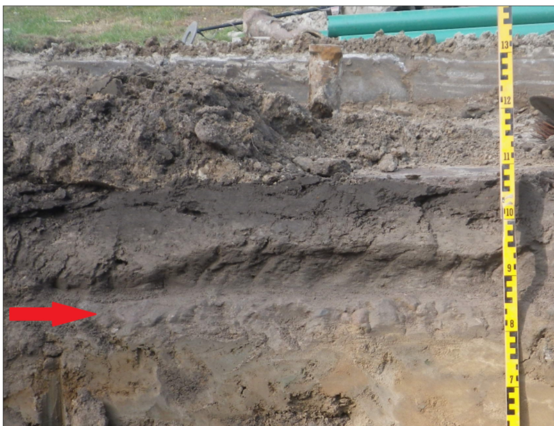
Afbeelding 11. Oud wegdek, zichtbaar als een lichtgrijs pakket tussen 80 en 100 cm op de meetlat (profiel 6, werkput 2). Aan de onderkant van het wegdek, aangegeven door de rode pijl, is een laag kleine veldkeien aangebracht.
